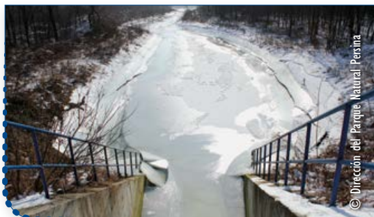
Esclusa de afluencia y canal que conectan los humedales con el Danubio
