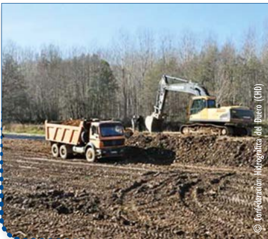
Trabajos de mejora de conectividad lateral del río y las dinámicas: retirada de terraplenes
