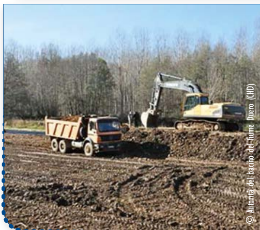
Lavori di miglioramento della connettività laterale e della dinamica del fiume: rimozione di argini in terra
