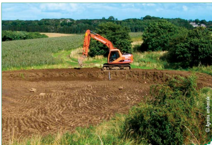
Uno stagno di raccolta fuori linea in costruzione nell'angolo di un campo
